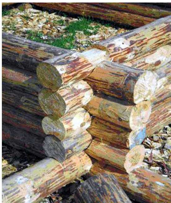
Attēls 3.12. Baļķu salaiduma vietas un šķēsgriezums; (source: www.lesoryb.ru )
