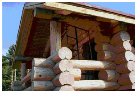
Attēls 3.10. Baļķu izvietojums gulbūvē; (source: www.lesoryb.ru )
