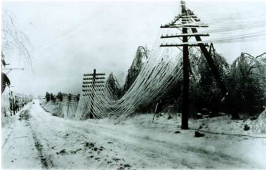
Figura 1 – Cables eléctricos cubiertos de hielo
