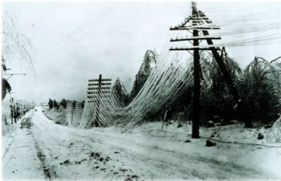
Abb. 1: Mit Eis bedeckte Stromkabel
