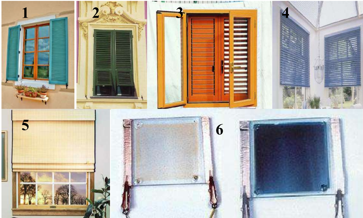
Abb. 2.2.2.4.d – Der Prozess des Anstiegs des Grades an Dynamik für einen Fensterladen: 1) der klassische unelastische Holzfensterladen; 2) ein Fensterladen mit der Möglichkeit zur Hälfte geöffnet zu werden; 3) ein Fensterladen mit vielen beweglichen Latten; 4) eine Jalousie; 5) ein Rollo; 6) ein selbst dunkelndes Glas.
